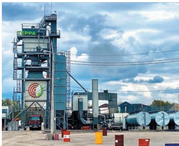
Асфальтобетонный завод в индустриальном парке «Юбилейный». Стоимость проекта более 160 млн рублей. Создано 35 рабочих мест
