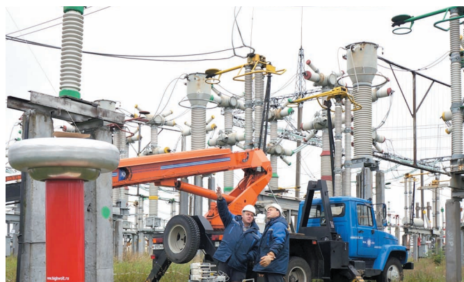
Валерий Цуканов и Виктор Стекачев выполняют поверку трансформаторов напряжения на месте эксплуатации
