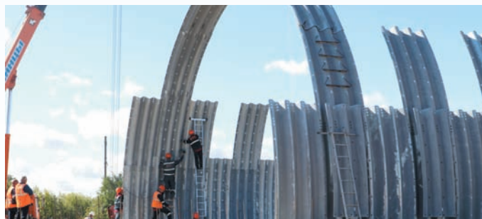
На путепроводе приступили к возведению арки через железную дорогу
