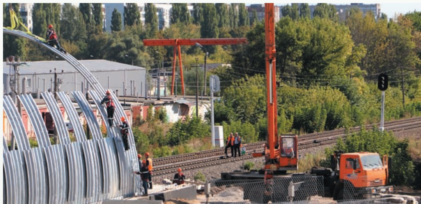
Путепровод в Курчатове возводят быстрыми темпами
