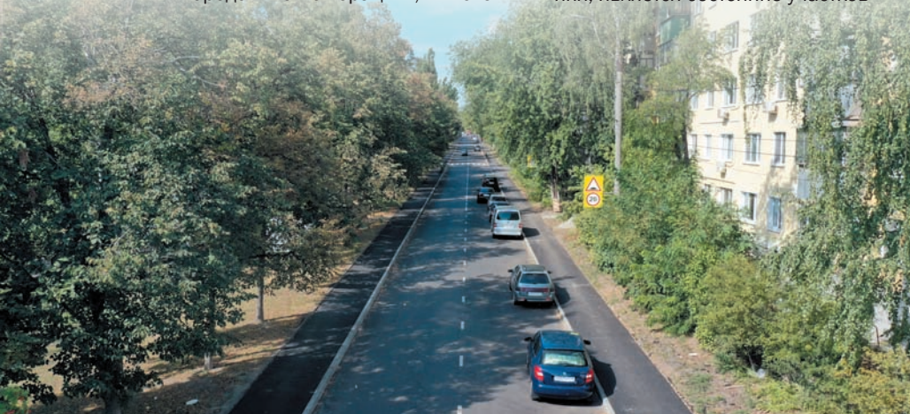
После ремонта дорога стала на загляденье...
