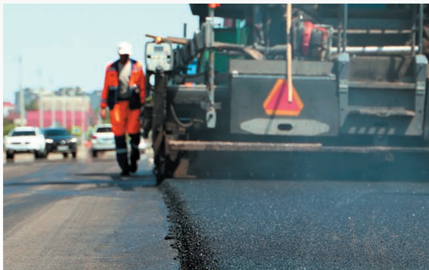
Идет укладка нового асфальта
