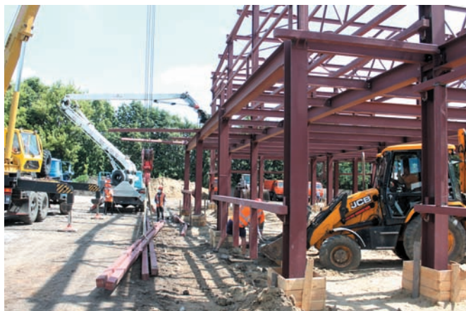
Строительство ФОКа в п. Горшечное
