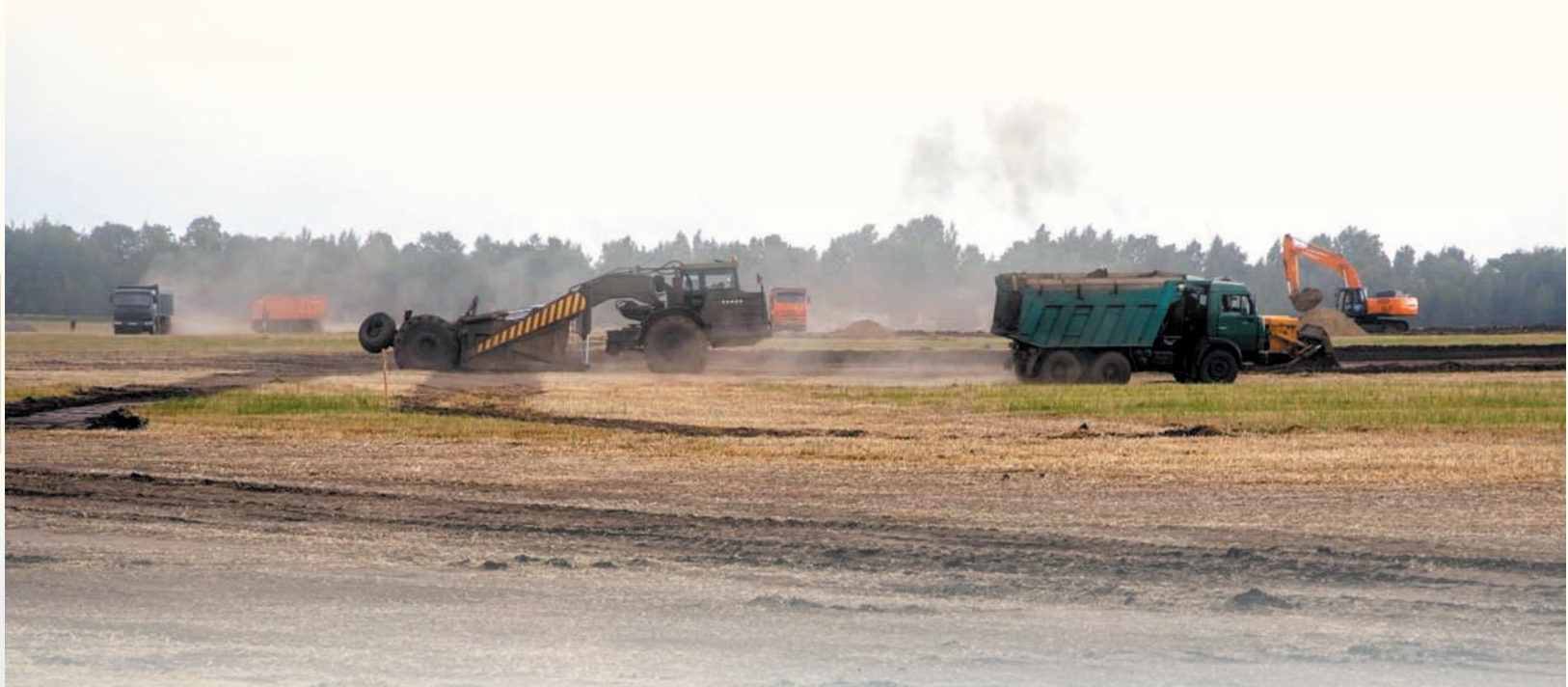
Строительство нового животноводческого комплекса идет полным ходом
