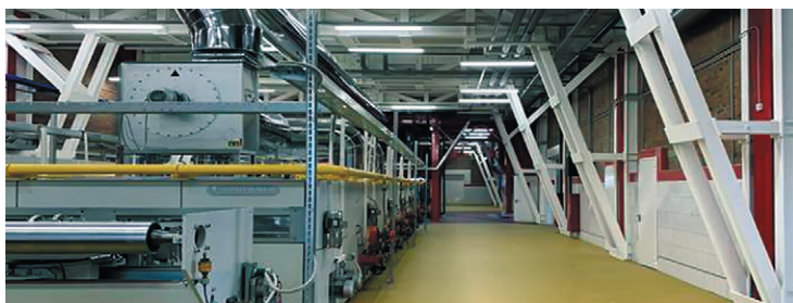
Реконструкцию цеха по пропитке и термообработке технических тканей, монтаж оборудования ОАО «Курскресинотехника» доверило мастерам «ГРП»
