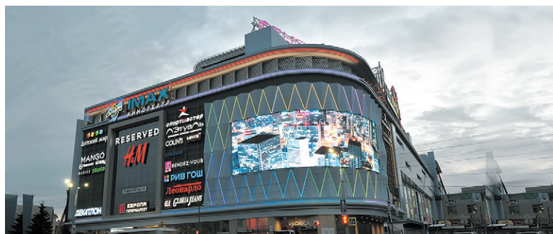
В сооружении инженерных сетей ТЦ «Европа» участвовали и работники многопрофильной строительной компании
