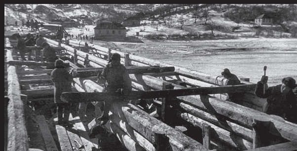
На строительстве автогужевого моста через реку Тускарь
