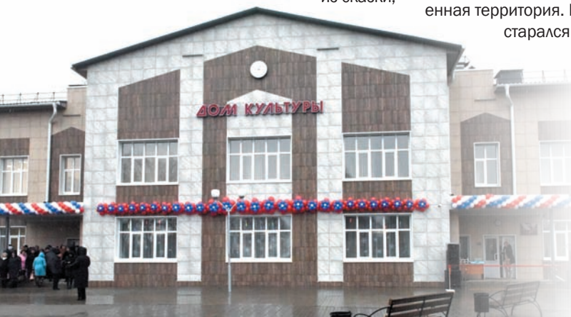
Новый Дом культуры Курчатовского района в поселке им. К. Либкнехта открыт в декабре 2019 г.
