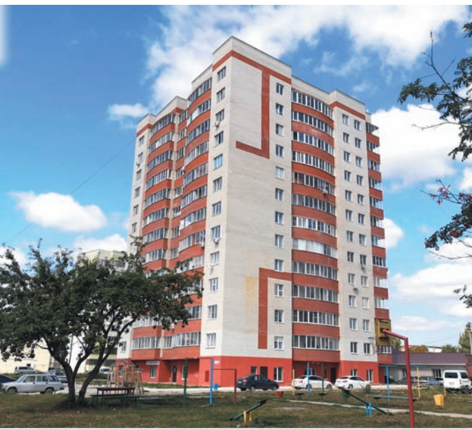
Дома, построенные ООО ГК «Курскспецстроймеханизация», ждут новоселов
