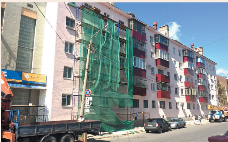
Фасадные работы близятся к концу
