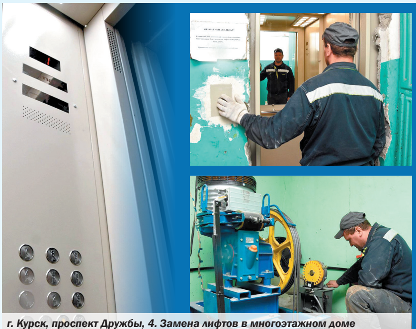
г. Курск, проспект Дружбы, 4. Замена лифтов в многоквартирном доме
