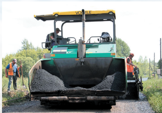
Идет укладка асфальта
