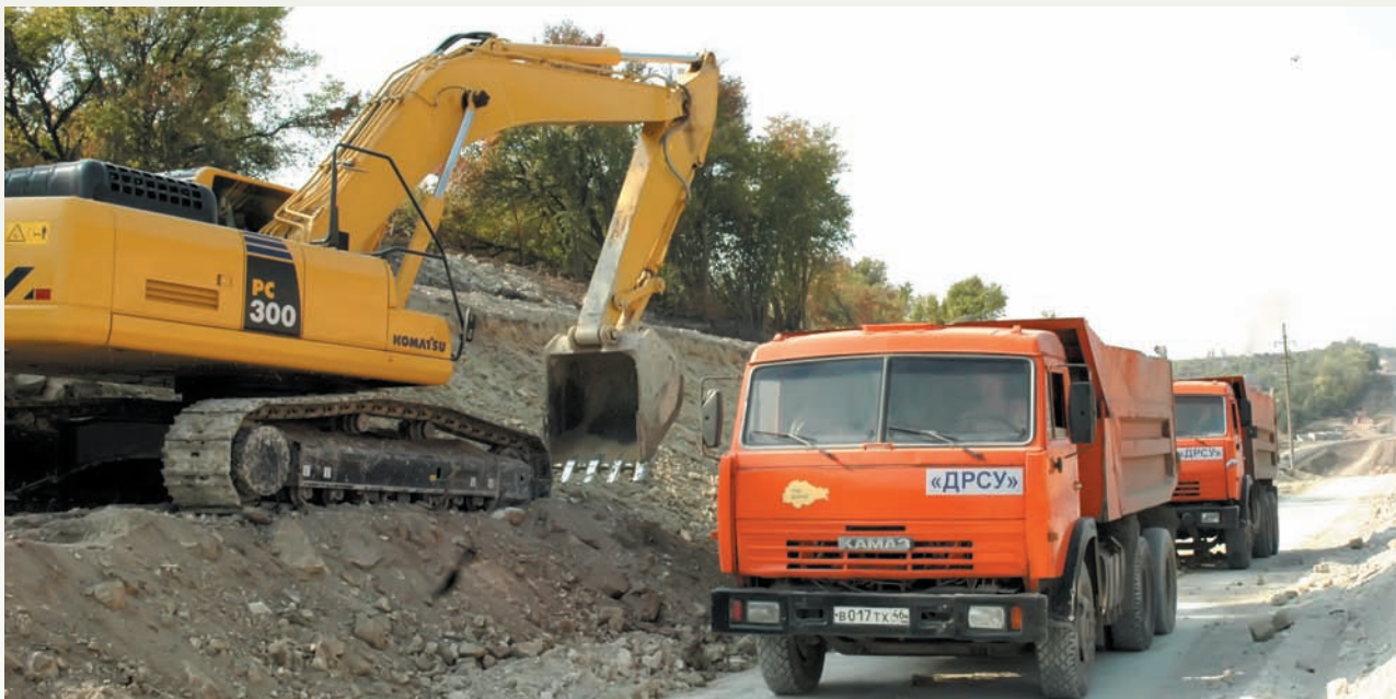
На погрузке грунта
