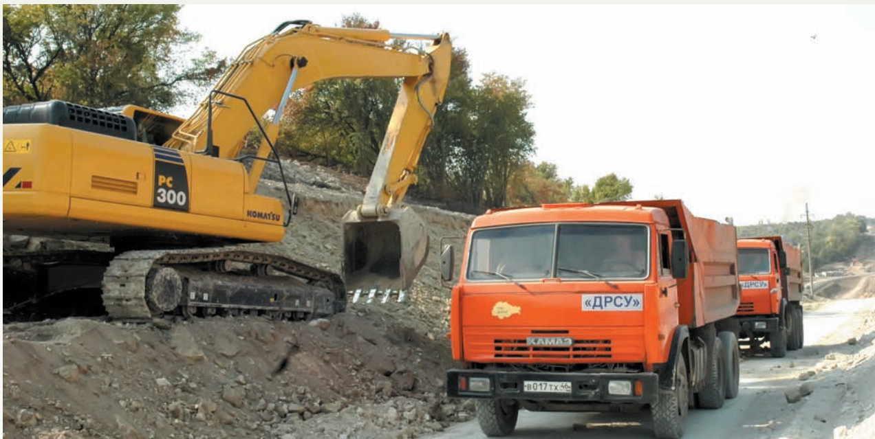
На погрузке грунта
