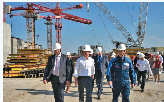
Визит врио губернатора Курской области Романа Старовойта на строительную площадку КуАЭС-2
