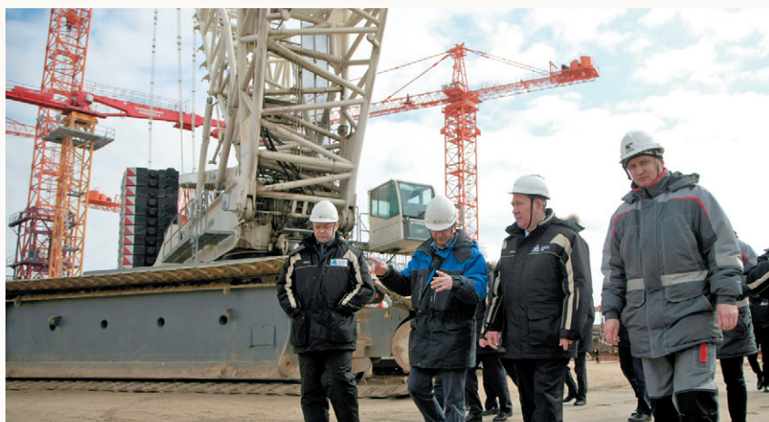
На объекте стратегического значения КуАЭС-2. Важно оценить ход строительства своими глазами
