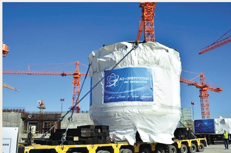
АО «Энерготекс» перевезло «ловушку» расплава на стройплощадку КуАЭС-2. 2018 год
