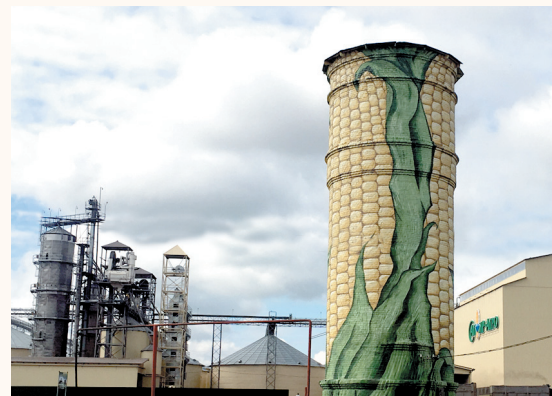
Водонапорная башня на фоне элеватора в виде початка кукурузы
