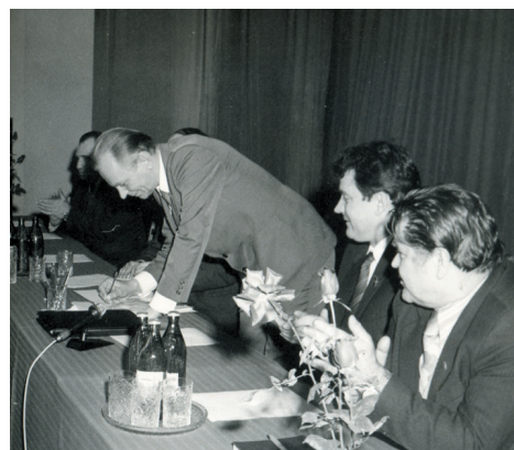
Декабрь 1985 года. Председатель комиссии Э.Н. Поздышев подписывает акт о приемке в эксплуатацию 4-го энергоблока Курской АЭС, построенного управлением строительства Курской АЭС. Принят с оценкой «отлично»
