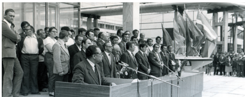
Митинг по случаю сдачи в эксплуатацию энергоблока – знаменательное событие для многотысячного коллектива строителей и жителей города Курчатова
