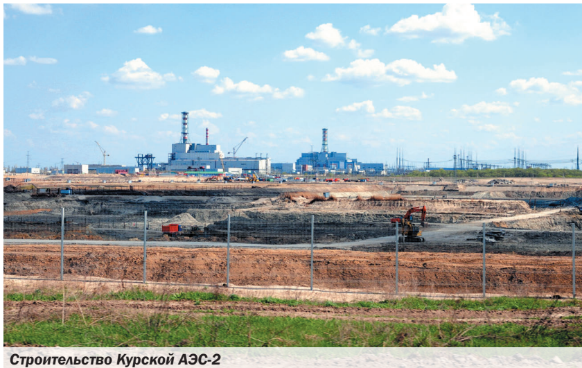
Строительство Курской АЭС-2
