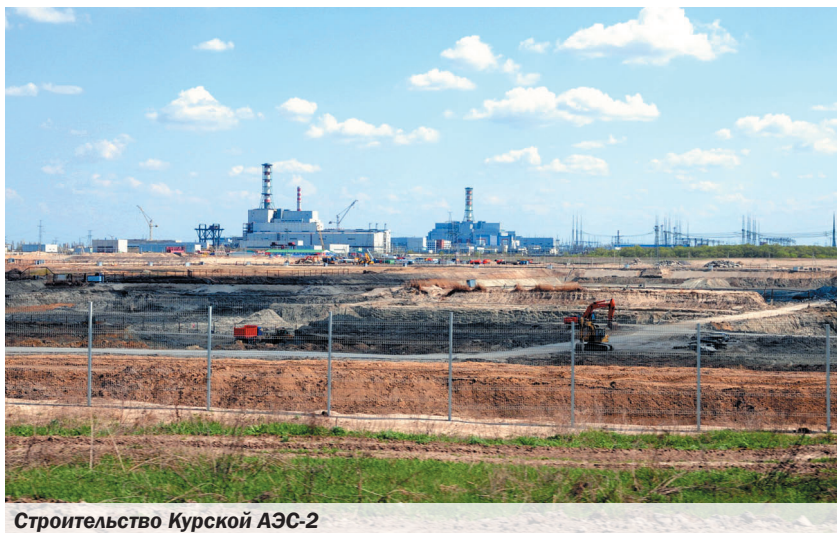
Строительство Курской АЭС-2
