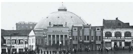
Всего несколько лет простоял на Красной площади стационарный цирк на 1220 мест, сооруженный по проекту архитектора П. Лазаренко. В годы войны был разрушен
