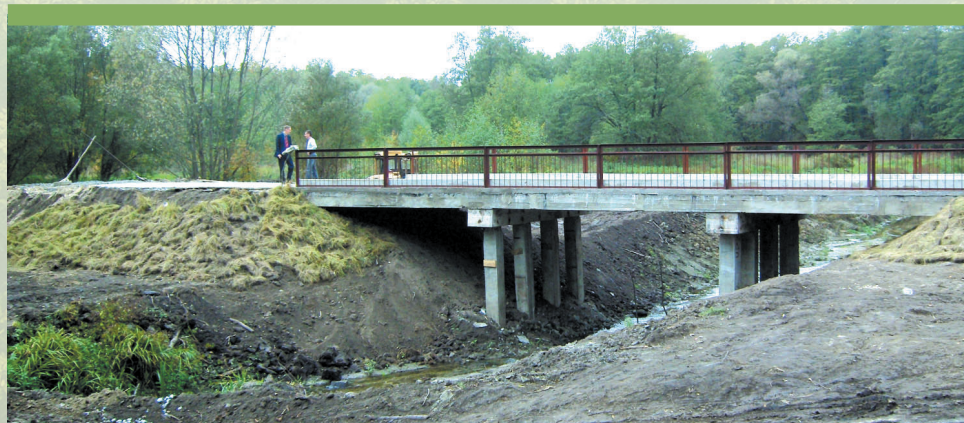
Строительство мостового переезда на магистральном канале. 2011 г.
