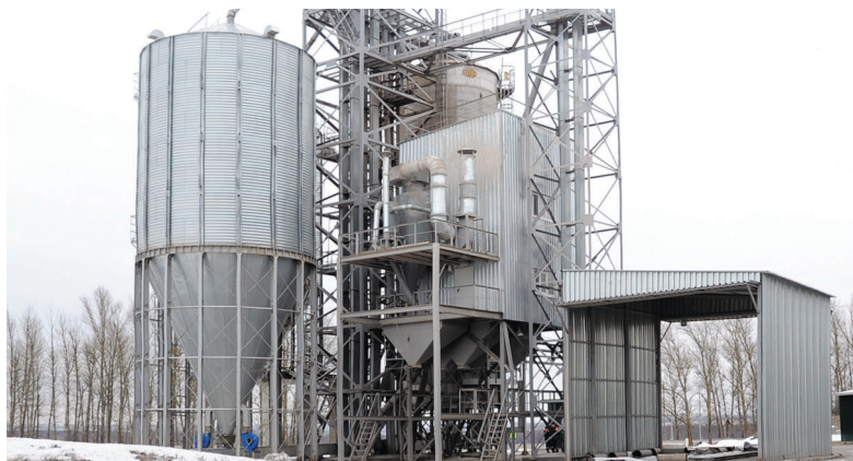
Современный зерносушильный комплекс выглядит весьма внушительно
