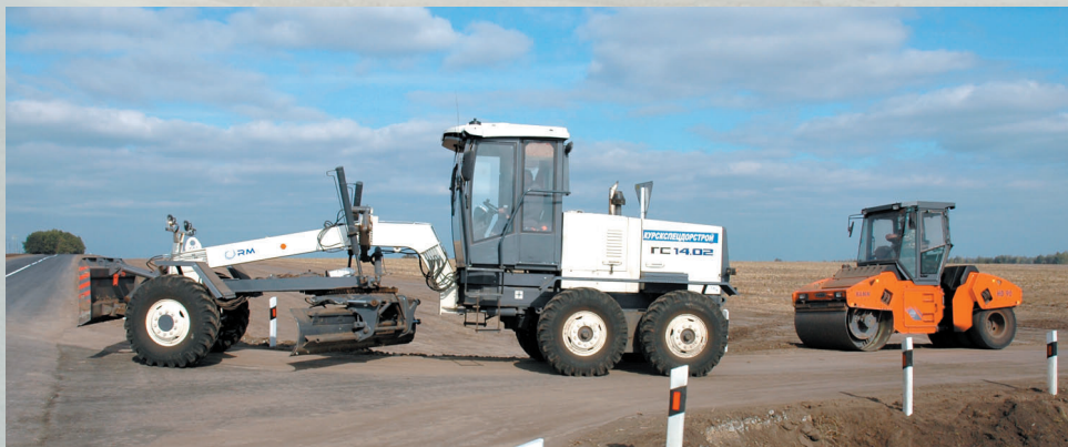
Через бескрайние поля Курской области проложены дороги, построенные коллективом Владимира Дурнева. Техника Курскспецдорстроя покидает автотрассу. До будущей весны!
