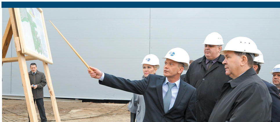
Губернатора Александра Михайлова знакомят с проектом очередного строительного объекта
