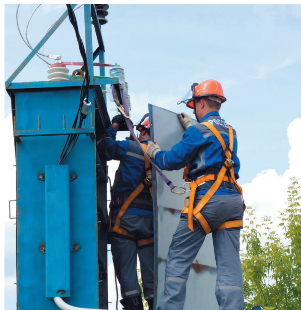
Бригада распределительных сетей проводит переключения на трансформаторной подстанции
