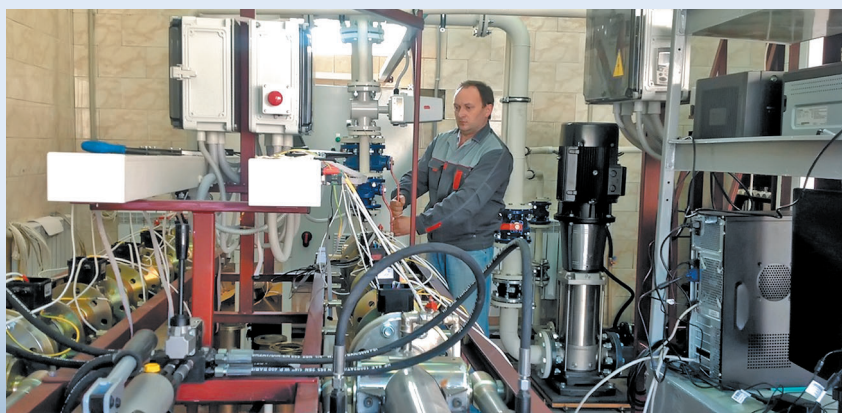
Запуск в эксплуатацию новой расходомерной установки УПРМ-С Теплоком 100-0,05/0,1/0,25 позволил расширить диапазон измерений и увеличить номенклатуру поверяемых счетчиков и расходомеров воды до 150 м³/ч
