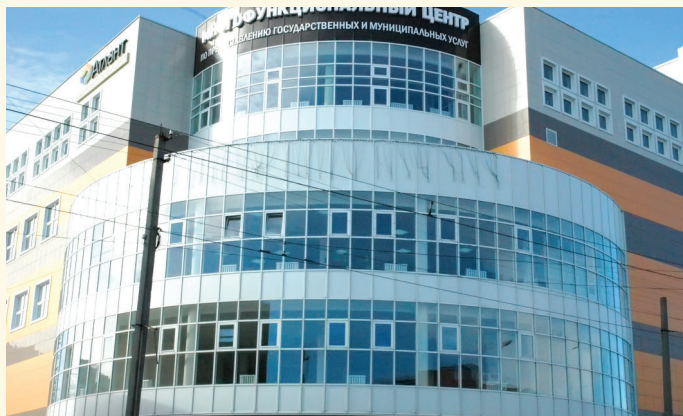
В этом здании расположился оздоровительно-реабилитационный центр «Атлант»
