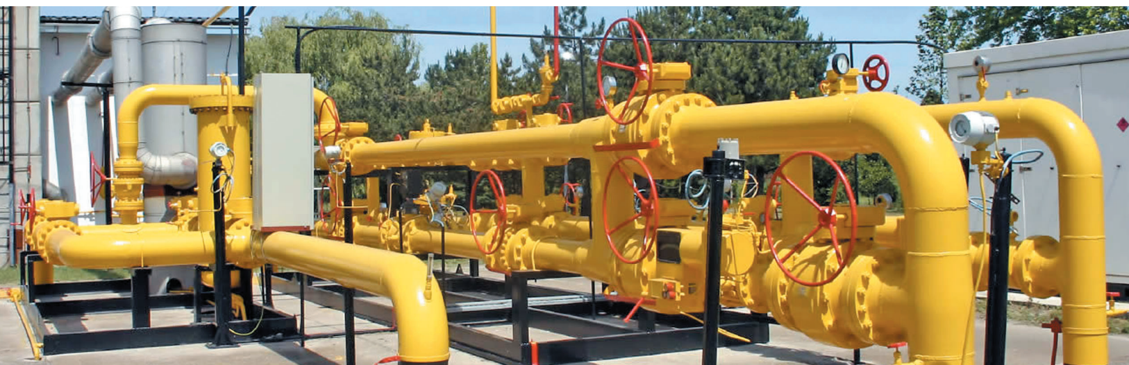
Десятки километров газопроводов проложены по Курской области коллективом, возглавляемым Р.Г. Саруханяном
