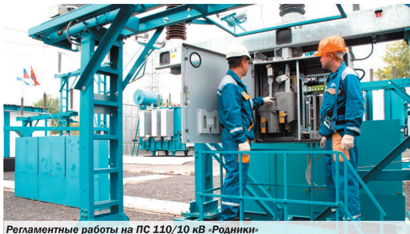
Регламентные работы на ПС 110/10 кВ «Родники»
