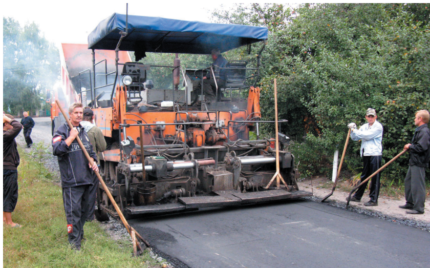
Начиная с 2010 года, в районе построено и отремонтировано более 70 километров дорог
