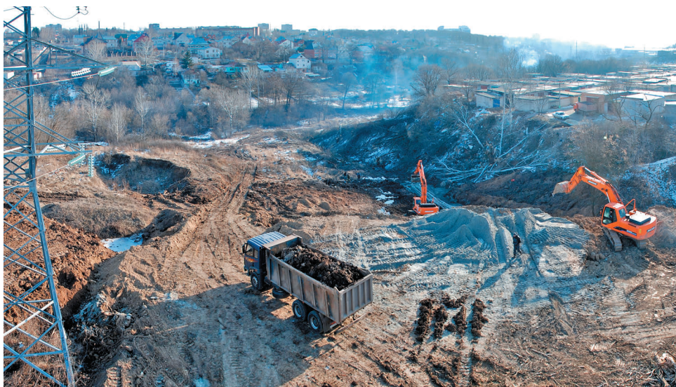
Развернулись земляные работы по строительству автомобильной дороги, которая свяжет проспект Клыкова с улицей Энгельса в районе здания Межрегионгаза
