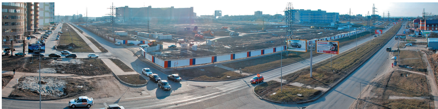
Здесь, у торгово-развлекательного комплекса «МегаГРИНН», строительство которого идет полным ходом, начинается дорога в сторону улицы Энгельса
