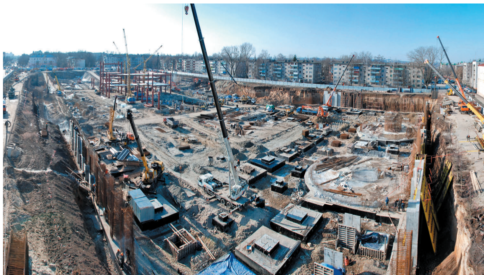
Полным ходом идут строительные работы по возведению многофункционального комплекса «МегаГРИНН» на улице Карла Маркса
