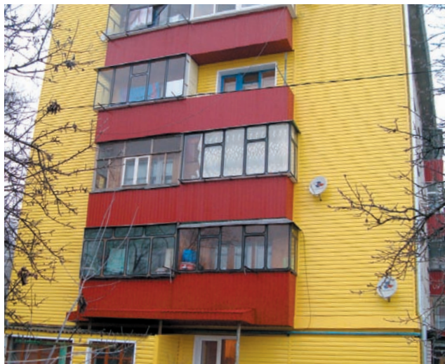
После капитального ремонта жилые дома в г. Курске обретают новый облик
