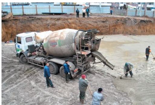
Здесь поднимутся этажи жилого дома, возводимого РеалСтроем
