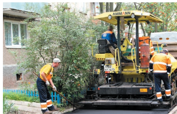
Идет ремонт внутриквартальных дорог
