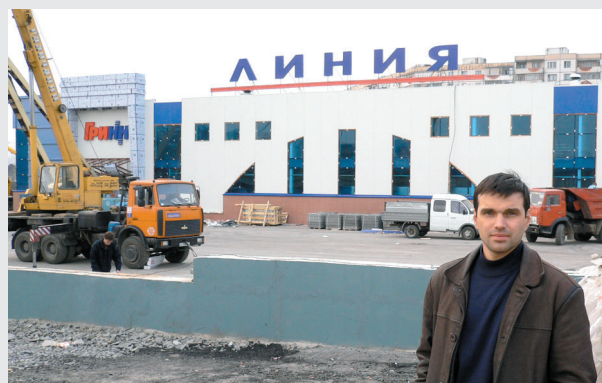
На строительстве очередного гипермаркета «ЛИНИЯ». Инженер по огнезащитной обработке Павел Волохов
