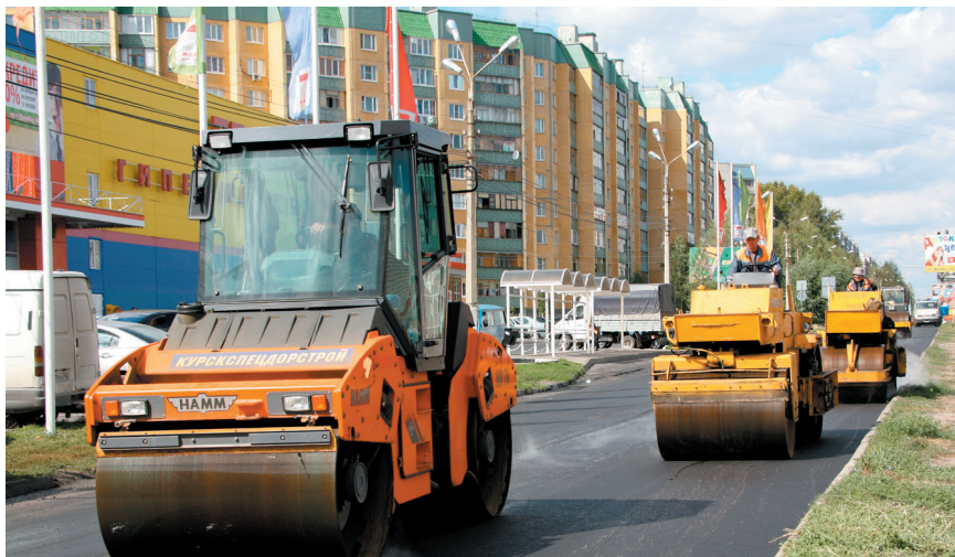
Курскспецдорстрой ремонтирует дороги областного центра
