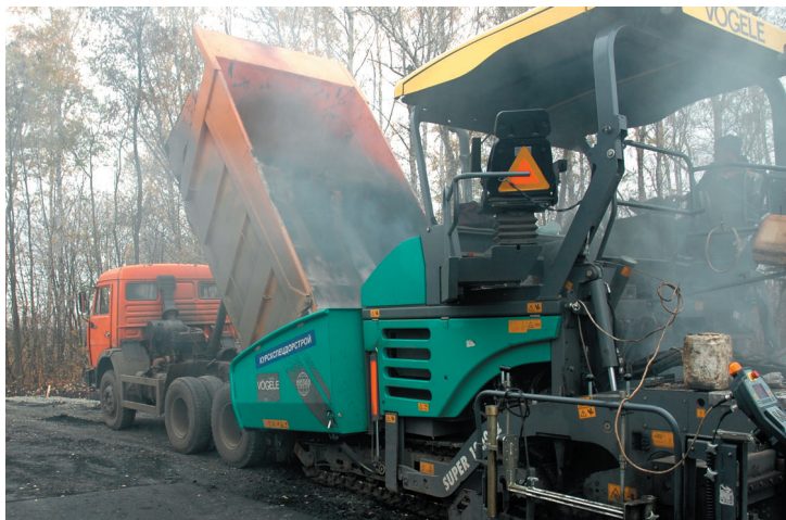
Горшеченский район. Строительство автодороги «Шляховы Дворы-Средние Апочки-Белгородка»
