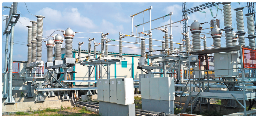
После реконструкции подстанции 110/10 кВ «Бекетово» повысилась надежность электроснабжения существующих потребителей и присоединенных объектов ЗАО «Курский Агрохолдинг»
