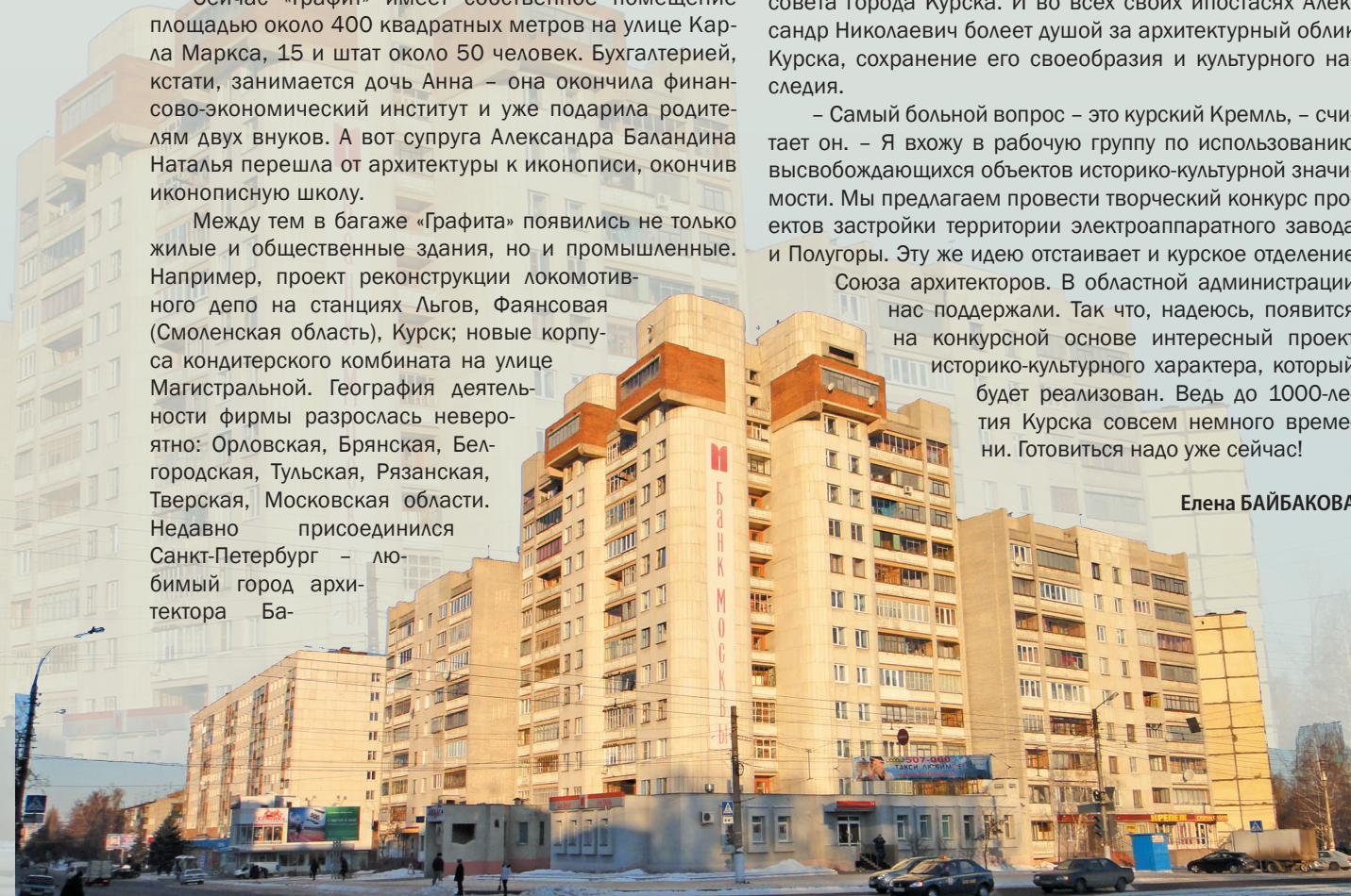
Жилой 9-12-13-этажный дом на ул. Союзной в г. Курске. 1988 год
