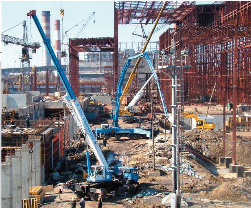
На строительстве третьей обжиговой машины по производству железорудных окатышей
