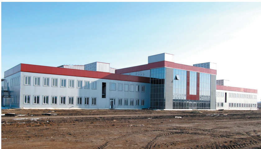
Строительство завода по производству функциональных протеинов ООО «Росана» на территории Валуйского района
