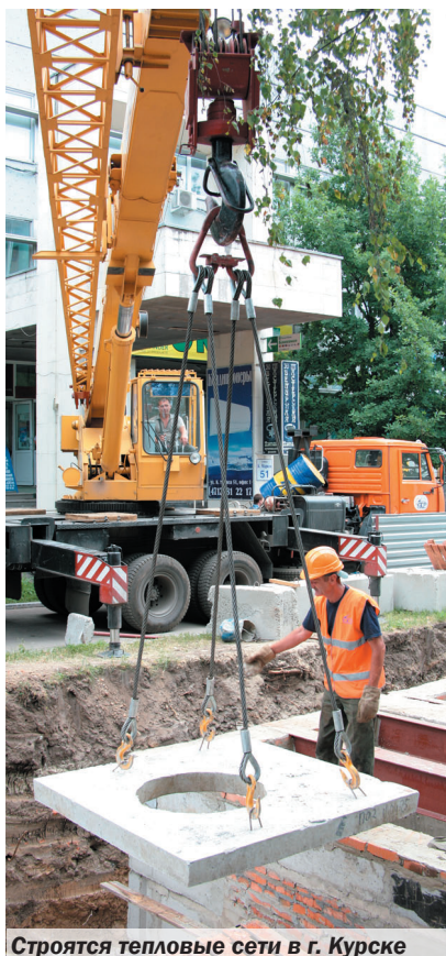
Строятся тепловые сети в г. Курске
