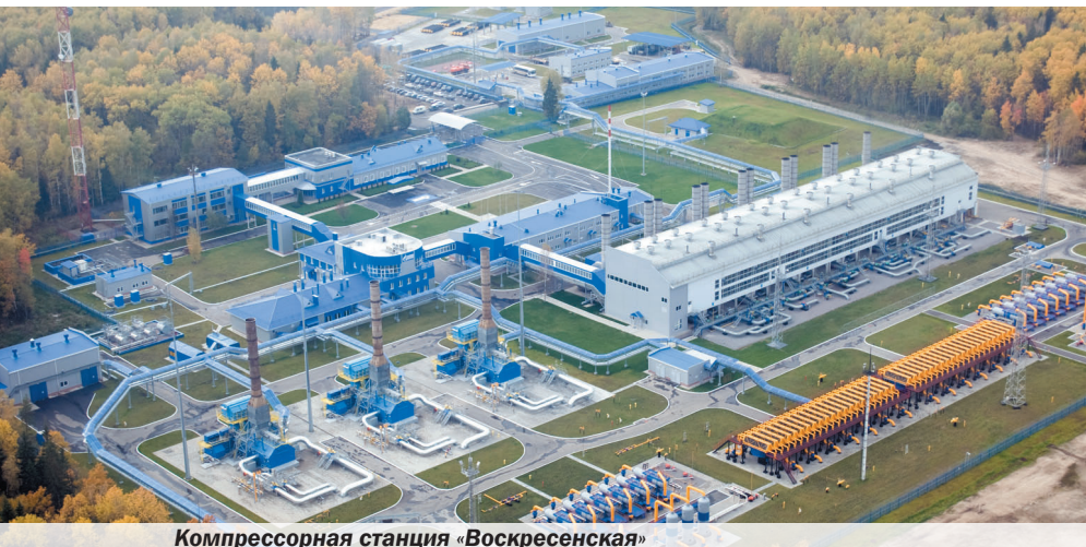
Компрессорная станция «Воскресенская»
