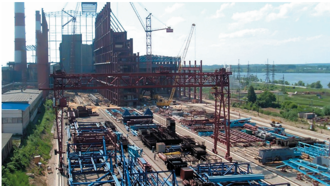
Строительство компанией ОГК-3 двух энергоблоков мощностью по 225 МВт на Черепетской ГРЭС
