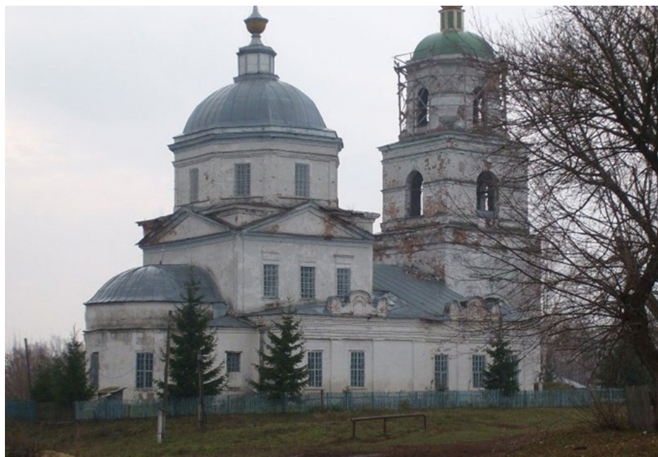
Никольская церковь с. Сосныч Глуховского района.
