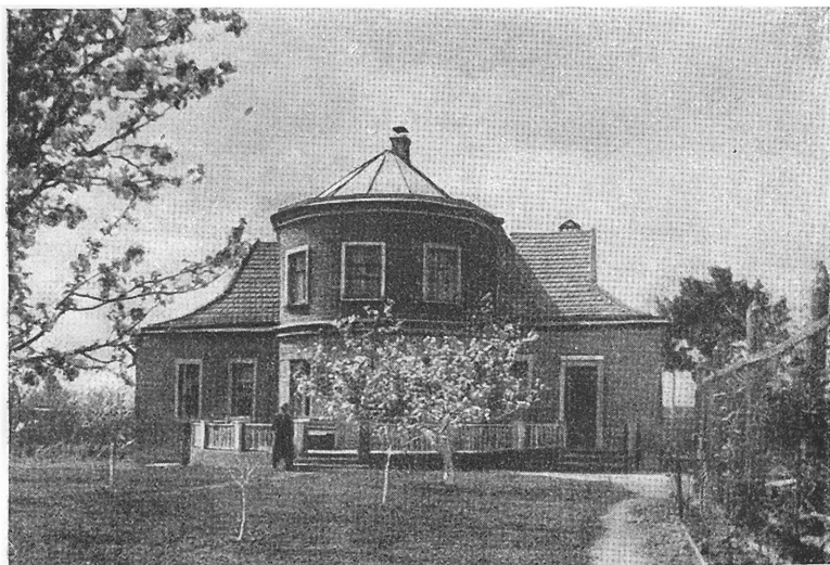
50. Особняк на Семеновской улице
