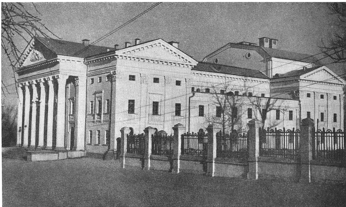
43, Клуб железнодорожников. Восстановлен и реконструирован в 1950 г. по проекту арх. Н. А. Вишнякова
