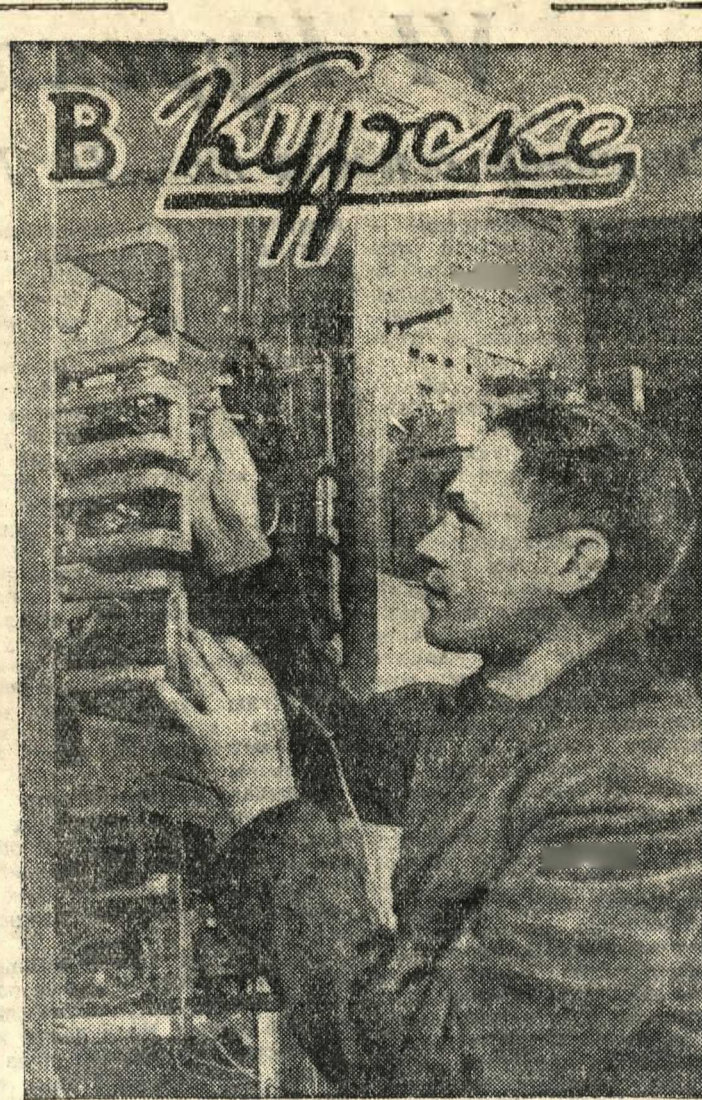
Мастерская Курской областной дирекции радиотрансляционной сети реконструирует радиоприемник Ленинского (сельского) района. Мощности узла значительно увеличивается.
