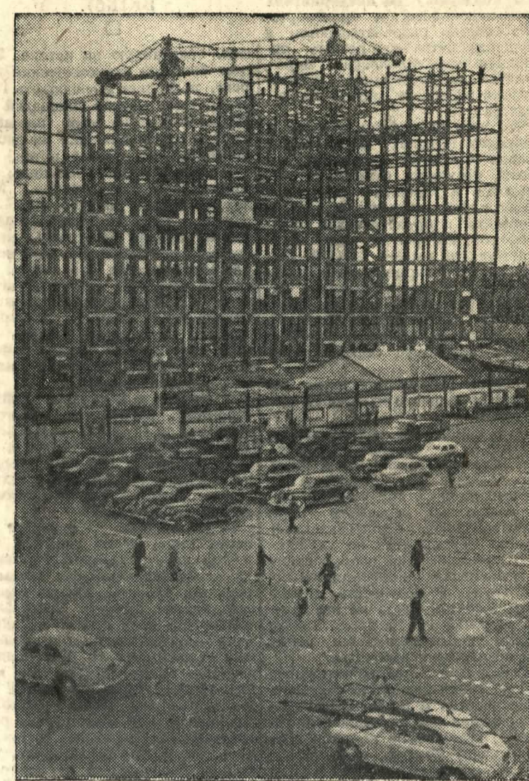
Москва. На Смоленской площади идет строительство 27-этажного административного здания. Работы по монтажу каркаса ведет трест «Стальконструкция». Детали каркаса изготовлены на Днепропетровском заводе имени Молотова. На снимке: строительство 27-этажного здания на Смоленской площади. Фото Э. Евзерихина.
