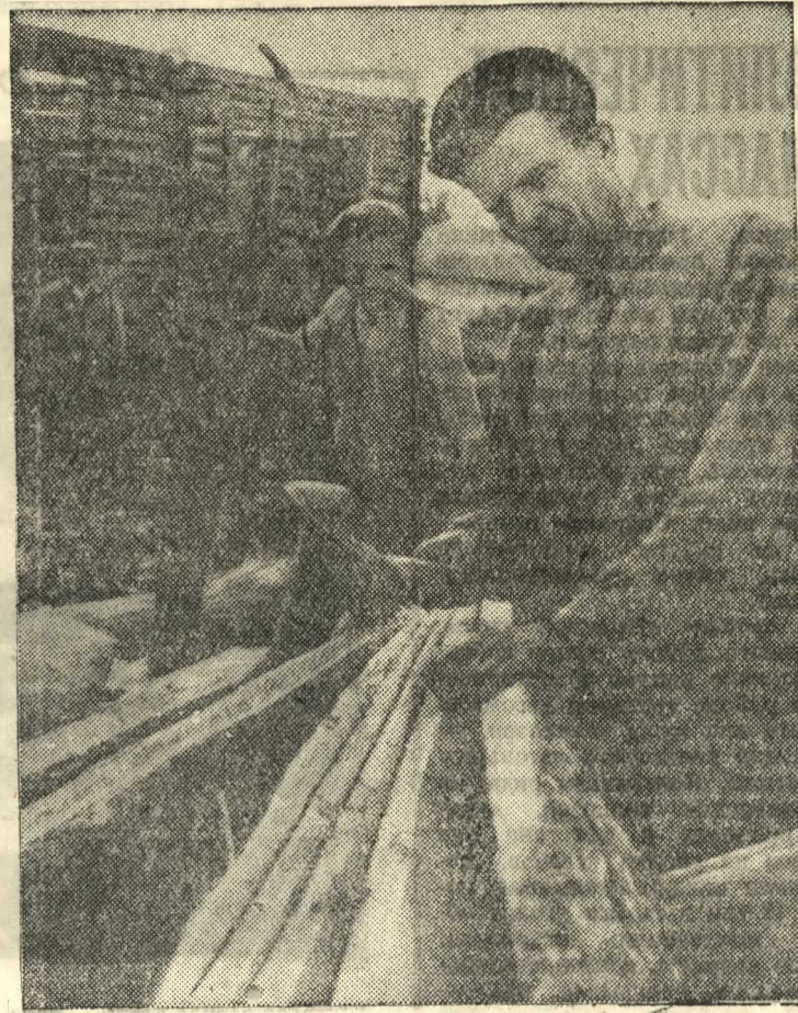
В колхозе «Зеленый гай» Корочанского района в этом году будет свой клуб на 300 мест. На снимке: строительство клуба. На первом плане плотник П. Субботин, Фото М. Шеховцова.
